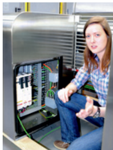
Anne Gerlach, Entwicklung ALUSTM/ GEA Lyophil, erläutert den Aufbau der PacDrive- Automatisierungslösung mit zentralisierter Stromversorgung für alle Servo-Komponenten.
