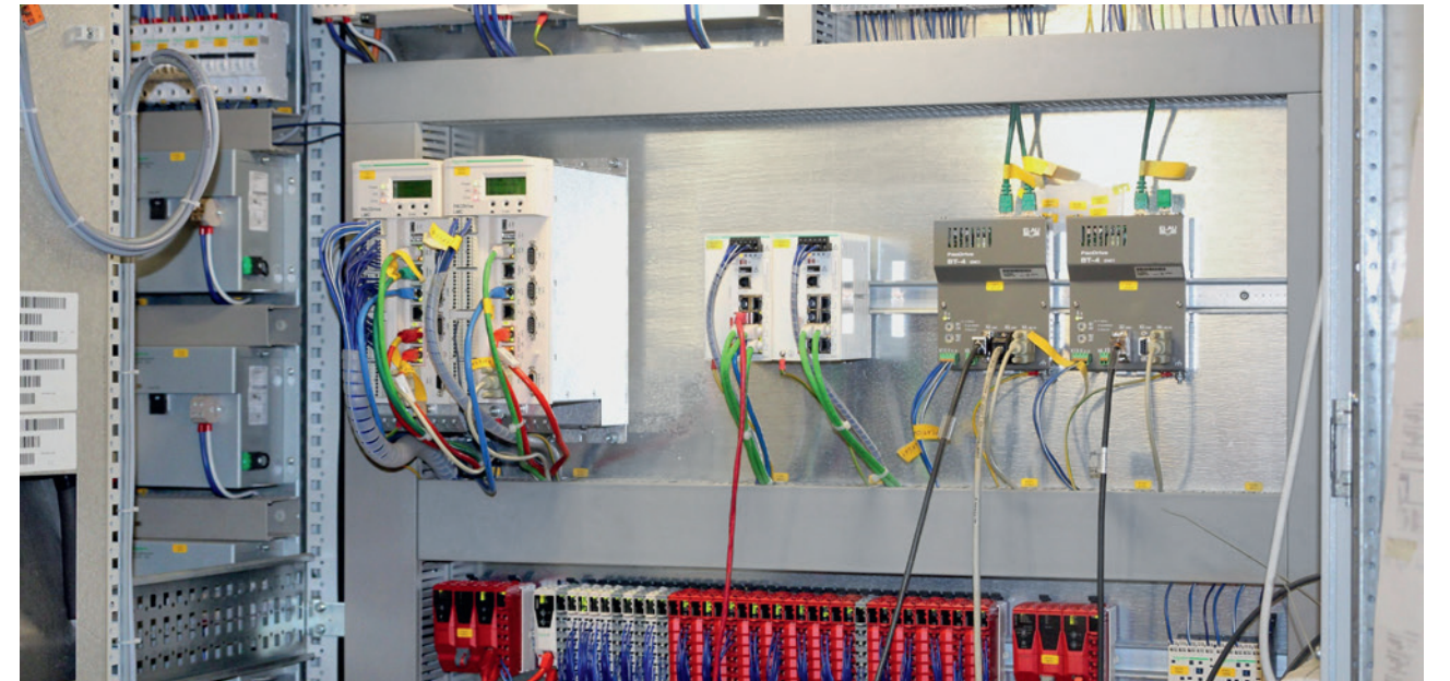
Bild 3: Die Steuerung der gesamten Anlage mit zwei parallel arbeitenden PacDrive 3 LMC Controllern, darunter zwei Sicherheitssteuerungen mit gemischtem I/O-Feld
